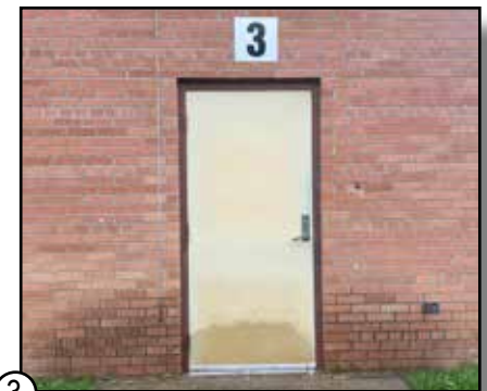
③ HOLLOW METAL DOOR & HOLLOW METAL FRAME
