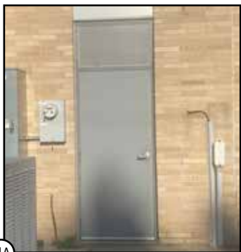
14A HOLLOW METAL DOOR & HOLLOW METAL FRAME
