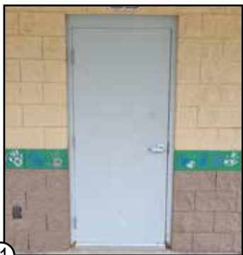
⑪ HOLLOW METAL DOOR & HOLLOW METAL FRAME
